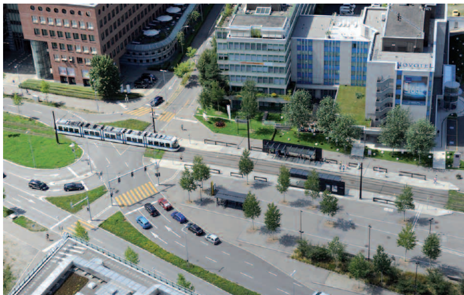
Abb. 4: Lindberghplatz Opfikon: Technische Ausgangslage im Untergrund – Herausforderung, die nur mit intensiver Koordinationsarbeit gelöst werden kann (Foto: Simon Vogt, sights).
